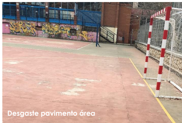
Estado del pavimento, desgaste de áreas.
